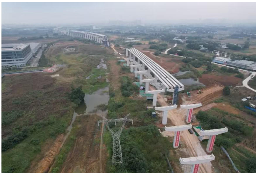
图 1：高架桥独柱墩段远景图
