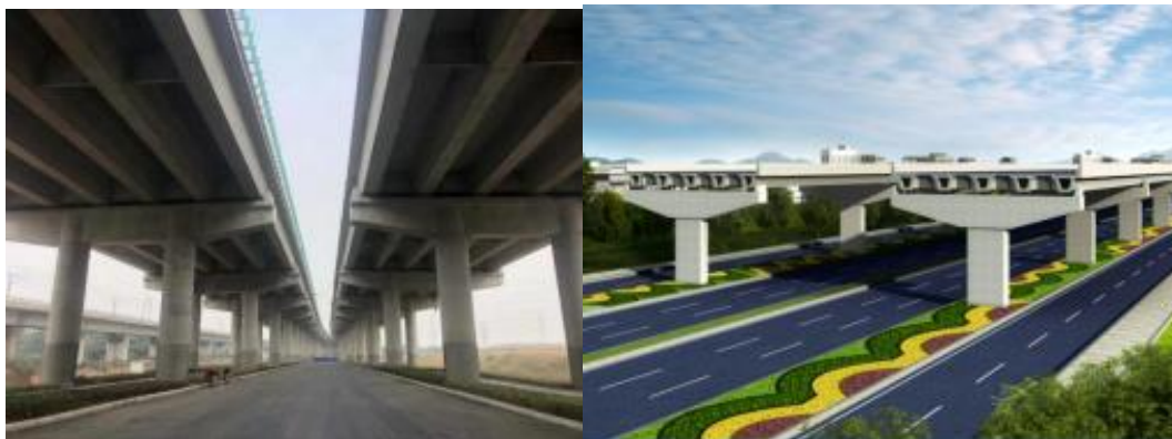
图 4：天府支线高架桥与底层道路
