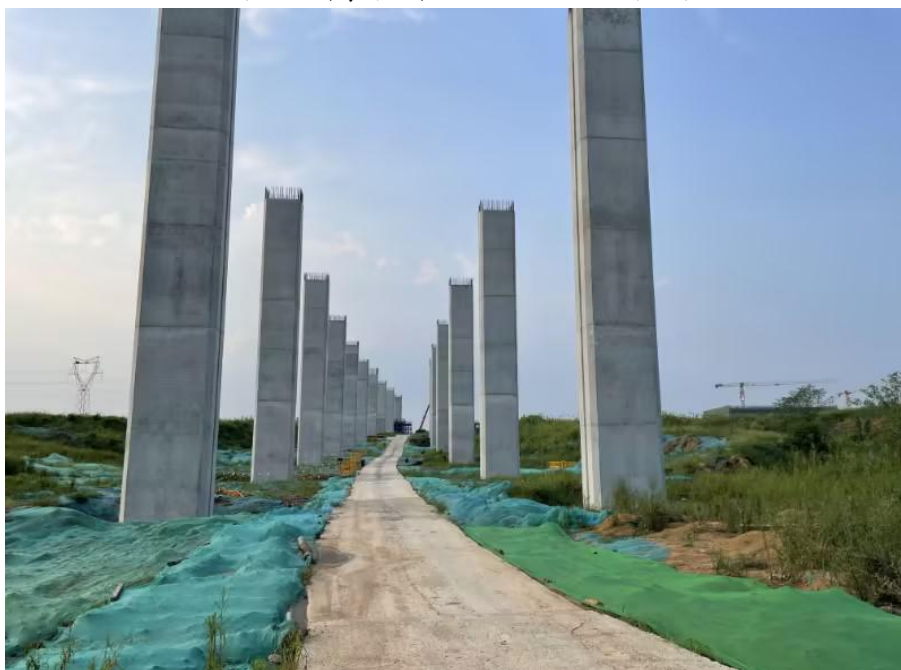
图 2：高架桥独柱墩段近景图
