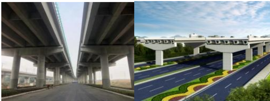
图 4：天府支线高架桥与底层道路
