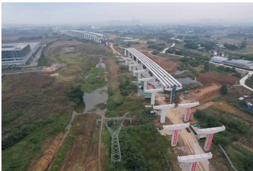
图 1：高架桥独柱墩段远景图
