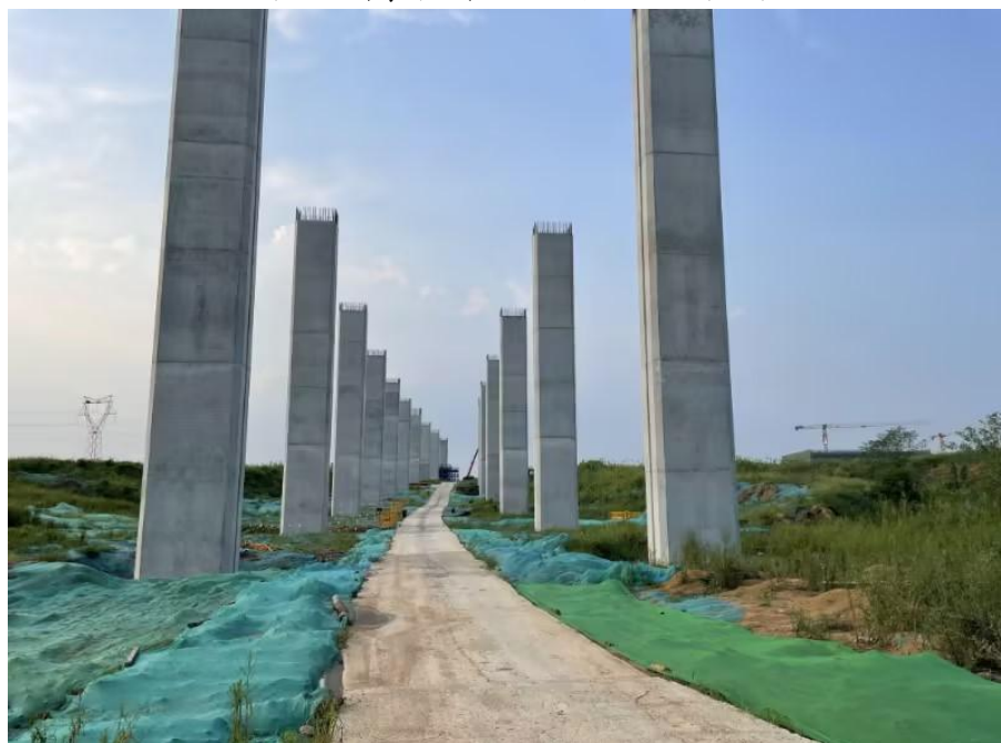
图 2：高架桥独柱墩段近景图
